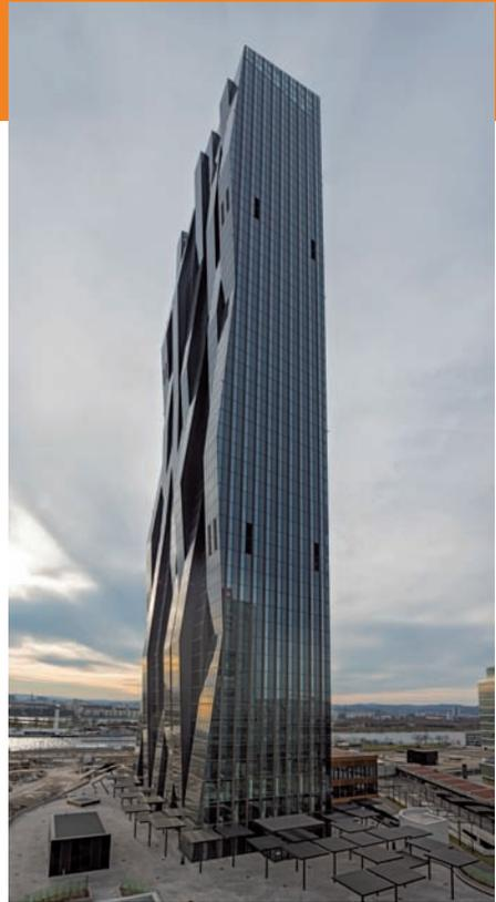
Das Tragwerk des DC TOWER 1 ist eine Kombination aus einem Stahlbetonkern und zwei massiven „Outtriggerkonstruktionen“.
