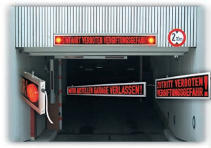
CO-Alarm: optische Warneinrichtungen gemäß ÖNORM M 9419:2017
