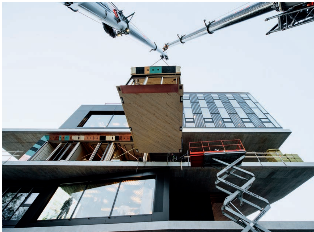
Einzelne Forschungs-Units lassen sich einfach in NEST integrieren. Rechte Seite: Der Anlagenstatus der Demonstratoren wird auf Multitouch-Control-Panels CP2915 per TwinCAT PLC HMI visualisiert.
