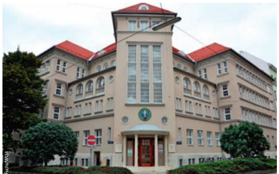
9. Bezirk, Lustkandlgasse 50 – Objekt der MA 34 mit Nutzung als Büro und Kindergarten.
